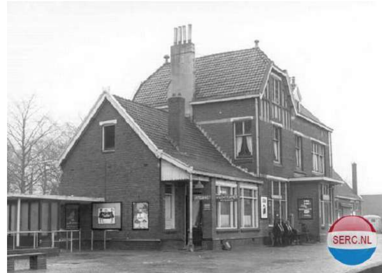
Het stationsgebouw uit 1905 (bron: www.fotos.serc.nl ).
